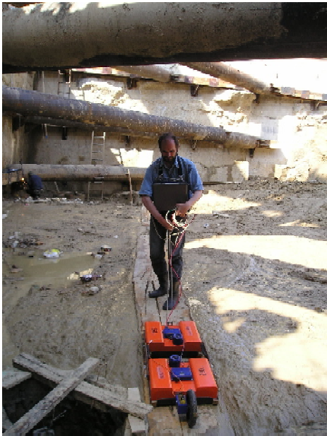
Рис. 12. Георадарное зондирование в котловане
