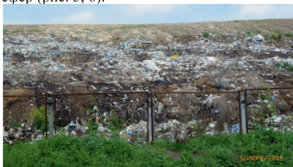
Рис. 6. Фотографічне зображення «тіла» східної частини черги «А» полігона № 5, на якому темно-коричневим кольором позначено місця височування і стікання фільтрату
